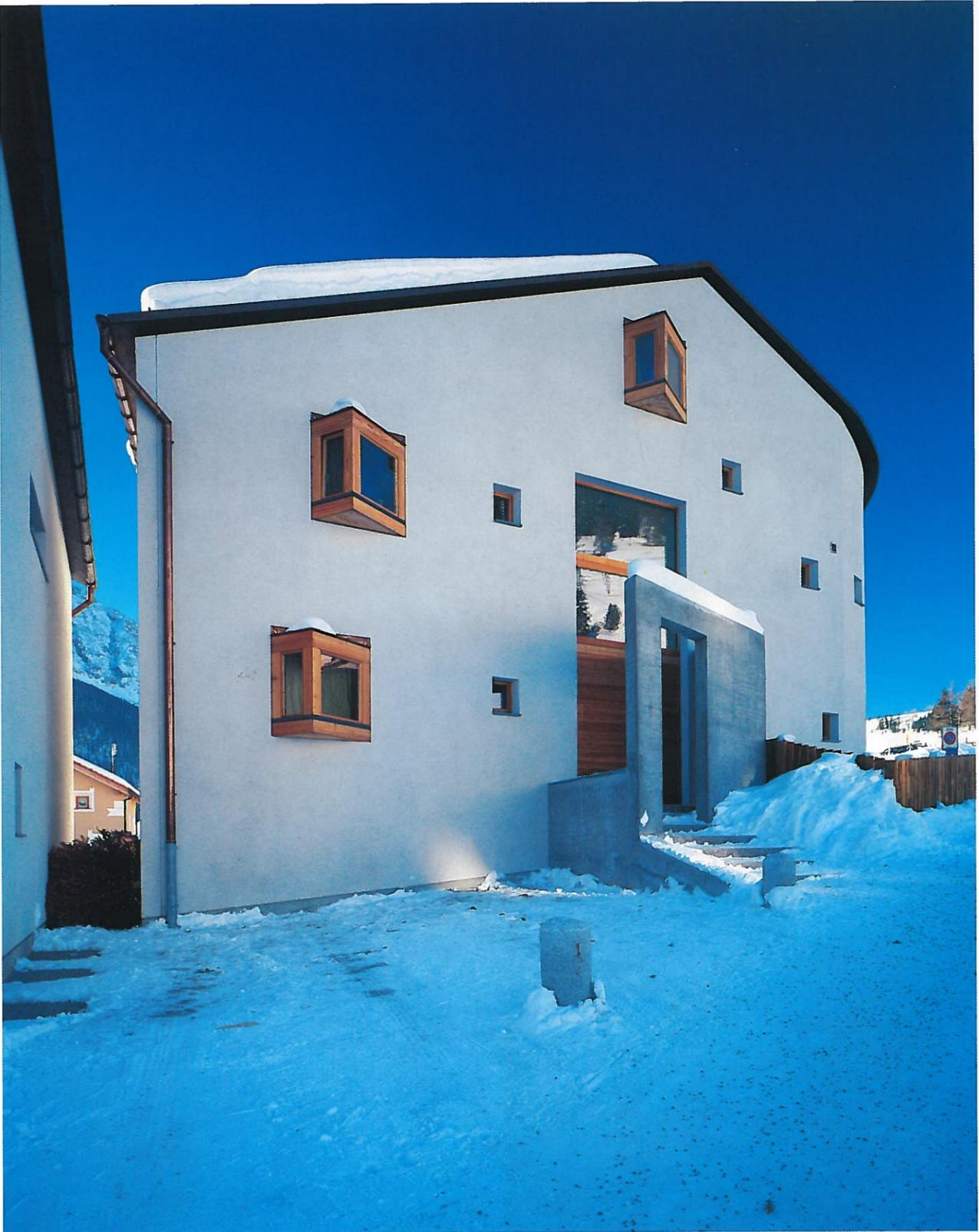
Gemäss den Lawinenvorschriften mussten bergwärts der Hauseingang sowie die Fenster, die sich öffnen lassen, geschützt sein. Die Architekten drehten die Fenster seitlich ab und schufen so eine neue Form von Erker.
