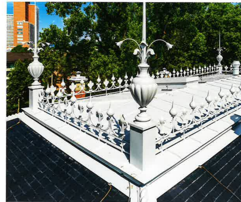
Die imposierenden Ornamente am Dach wurden aus Titanzink-Blech erstellt und nachträglich farbig angestrichen. Die neue Zinnen-Ornamentik dient und wirkt als Dachrand-Abschluss.
