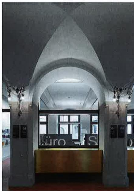
Architekten nutzten die Gelegenheit, strukturelle Schwächen und Mängel aus der Bauzeit zu beheben, insbesondere die Erschliessung der oberen Stockwerke. Dabei konnte die Fortsetzung der Haupttreppe ins vierte Obergeschoss jetzt verwirklicht werden. Der neue Treppenlauf besteht aus Flachstahl und ist als neues Element erkennbar, integriert sich aber dennoch selbstverständlich in das Raumgefüge des Treppenhauses.
