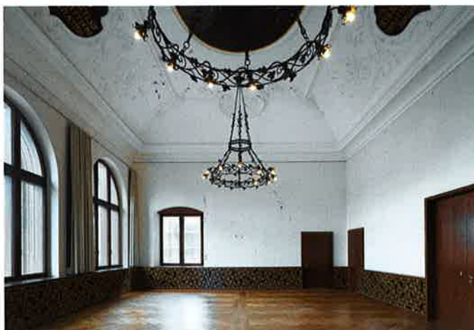
Sanierung der Fenster, ARGE Kneubühler und Ziebold, Zürich
