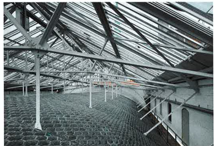
Ausführung der Glaskuppeln, Semadeni Glasbetonbau, Horgen-Arn
