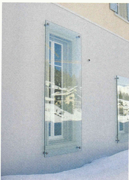
20 mm dickes Panzerglas schützt die Fenster des erneuerten Altbaus. Wohnpark Rosegg, Pontresina (Architekturbüro Hans Hirschi AG)
