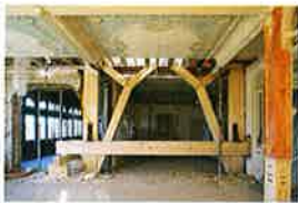
Sachseln: Hotel Paxmontana Abb. 5 Umfangreiche statische Massnahmen machen den fünfgeschossigen Holzbau erd- bebensicher.
