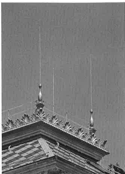
Rekonstruierter Dachkranz Couronne du toit reconstruite
