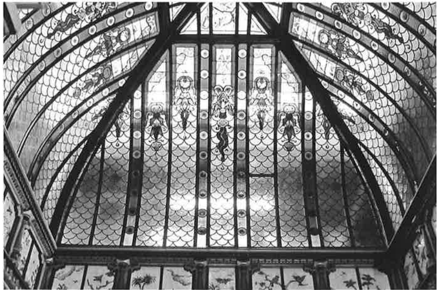
Oberlicht mit farbiger Bleiverglasung Lumière zénithale en vitraux de couleur
