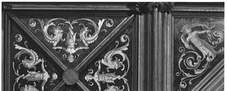
Salon im EG, restaurierte Kassettendecke Salon au rez-de-chaussée, restauration des plafonds
