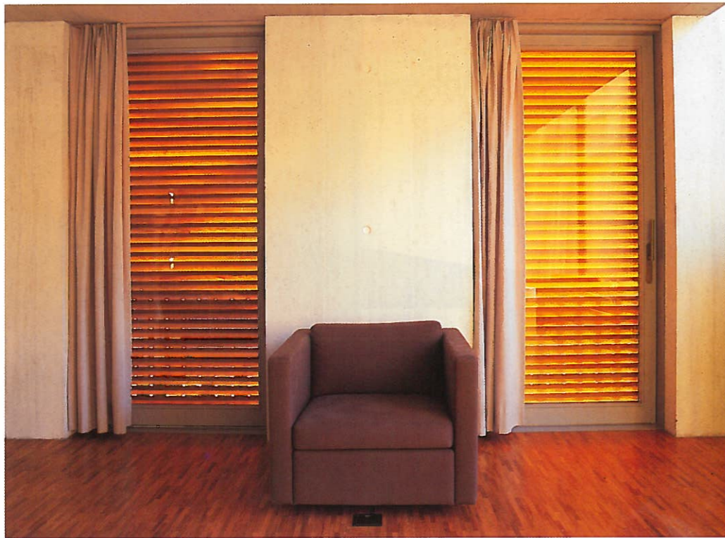
Die feingliedrige, schimmernde Schichten-Konstruktion filtert Sonnenstrahlen ins Innere, wo sie flirrende Spielräume auf dem Boden zulassen.
