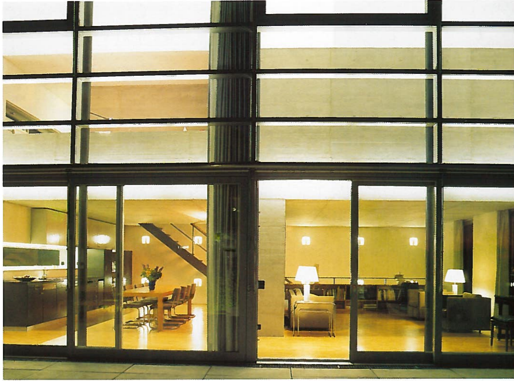
Der Hauptwohnbereich ist zum Übergang zum oberen Obergeschoss hin offen. Durch zwei Eingänge verbindet sich ein breiter, heller Lichtweg.
