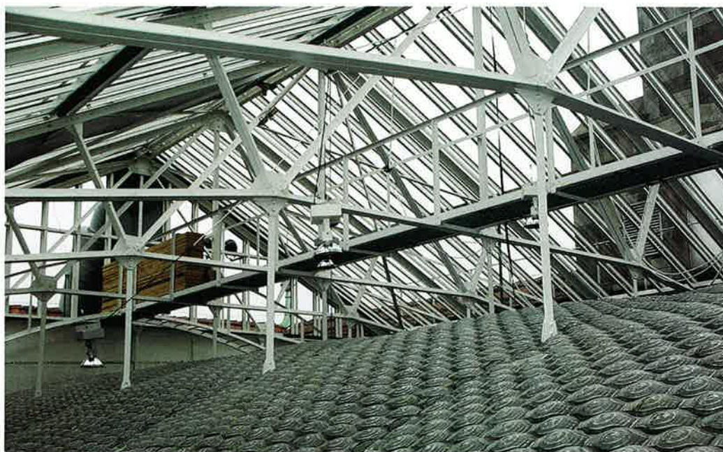
Über dem antiken Glasgewölbe befindet sich ein weiteres, modernes Glasdach mit einer Tragkonstruktion in Stahl. (Bilder: wa)
