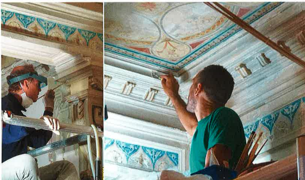
Gewisse Partien im Innern der Villa Patumbah sind bis zu sechs Mal übermalt.
