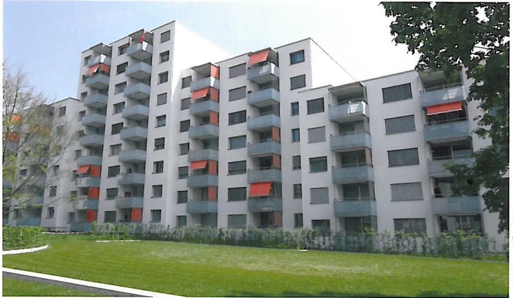
Die Pilotsanierung nach Minergie-Standard ermöglichte in der Mattackersiedlung der ASIG Energieeinsparungen von 41 Prozent.
