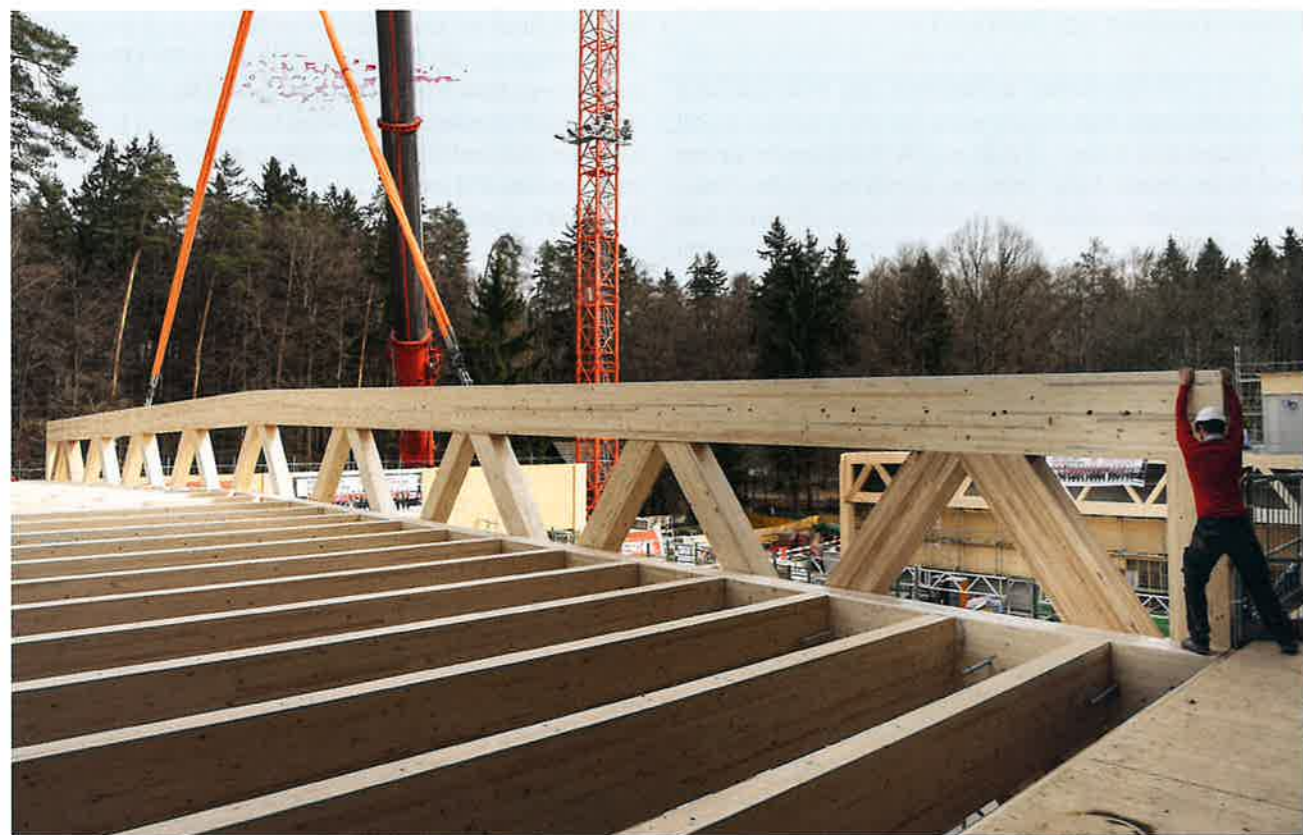
Einheben eines Fachwerkträgers. Die Pfetten werden mittels Schwerlastankern am Träger befestigt.
