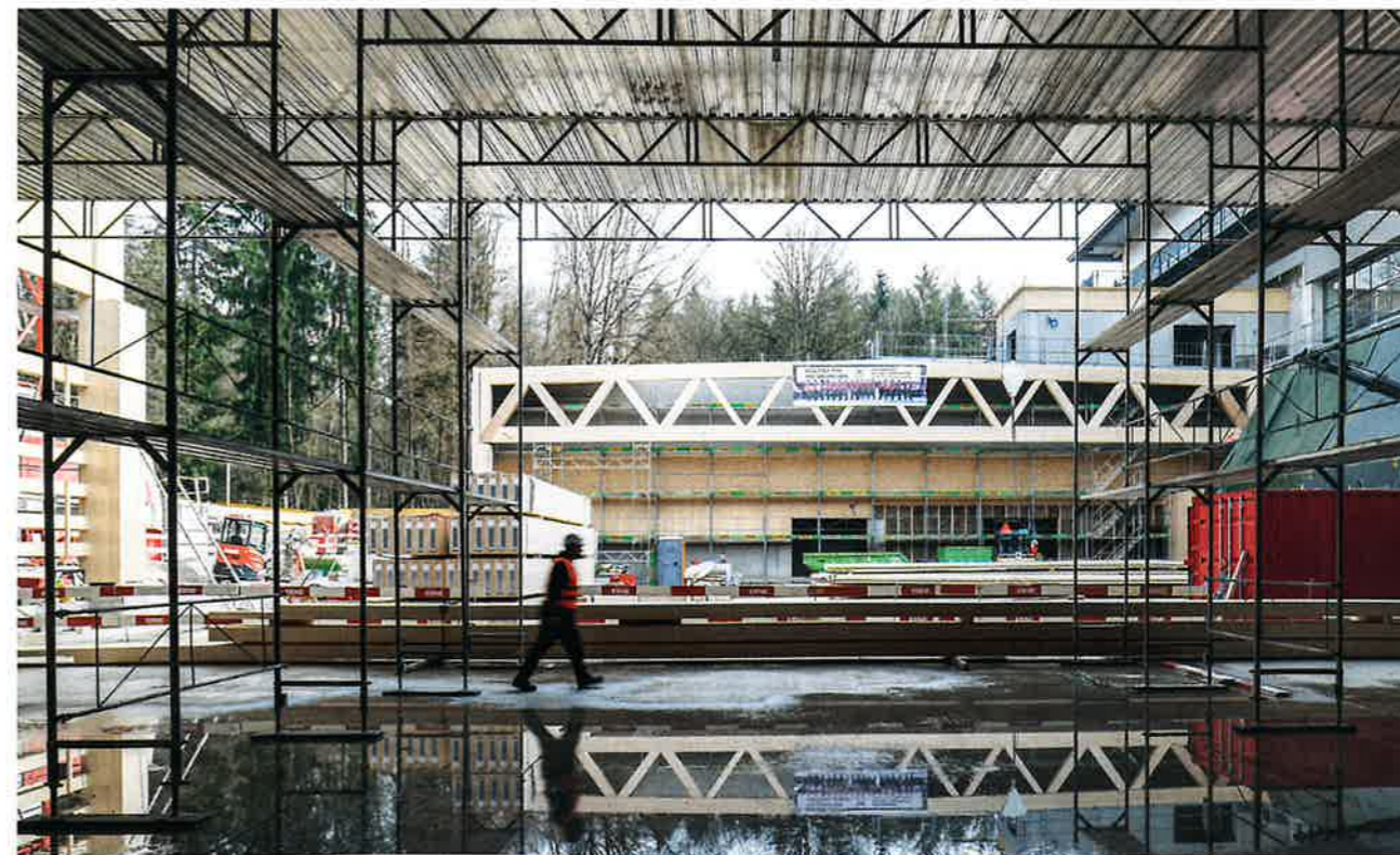
Errichtung der neuen Halle. Die massive Wirkung der Holzstütze (links) relativiert sich mit der Einbindung der Träger und der Entfernung (hinten).
