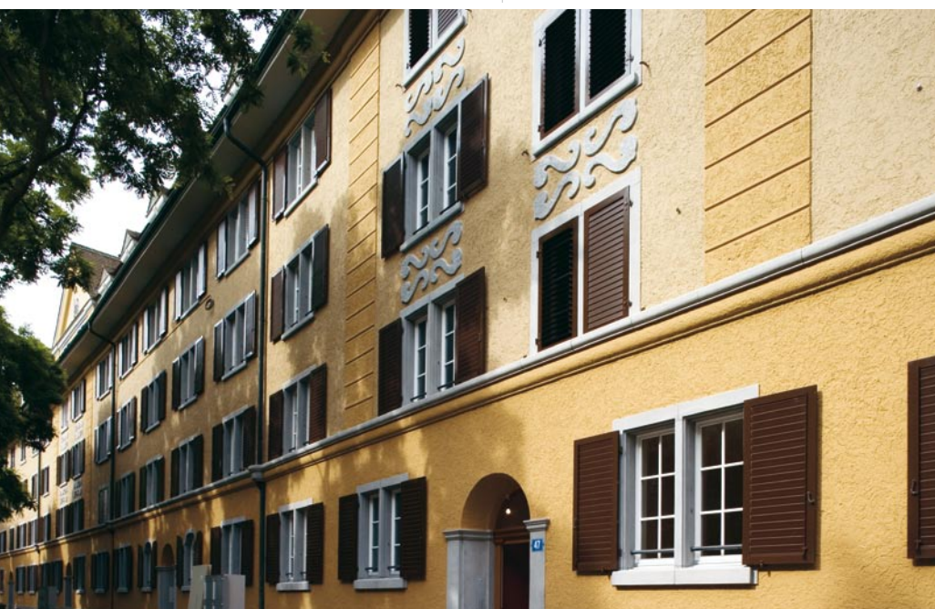
Die Fassaden gegen die Strassenseite durften nicht verändert werden.
