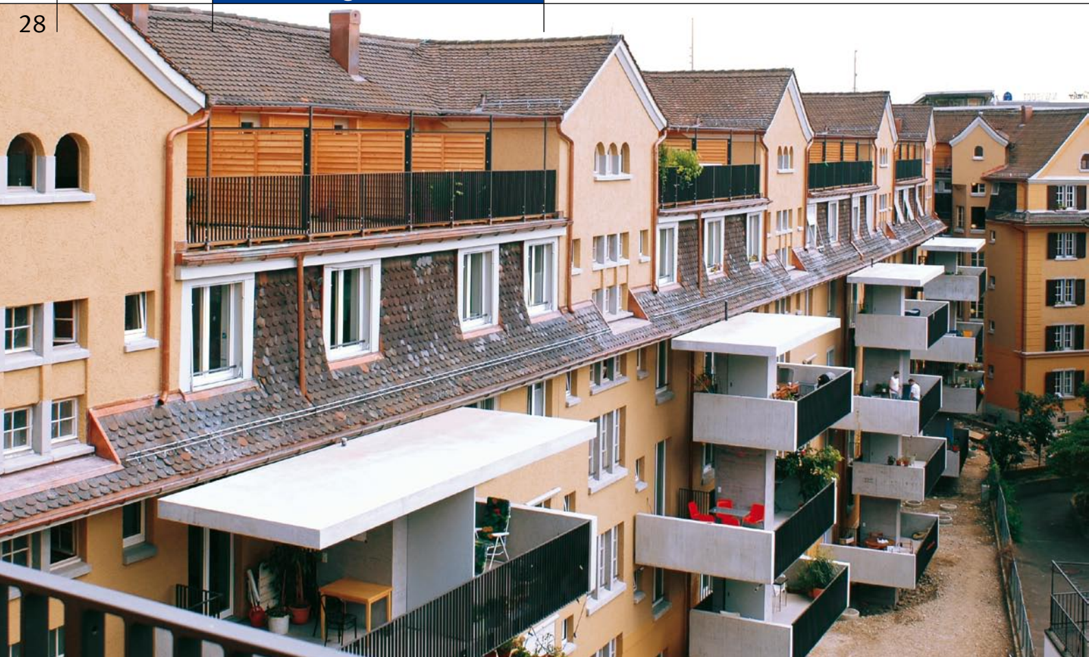
Blick in den Hof mit den neuen Balkontürmen und den individuellen Dachterrassen.
