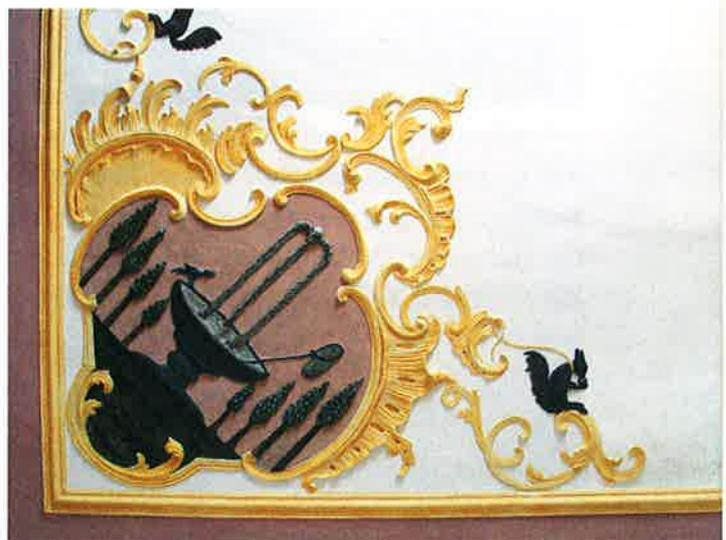
die zweite Fassung zu belassen, um darauf die Erstfassung zu rekonstruieren. Die zahlreichen Fehlstellen beim Stuck, die insbesondere durch eingezogene Zwischenwände und abgehängte Decken entstanden waren, wurden mittels Abgüssen geschlossen.
