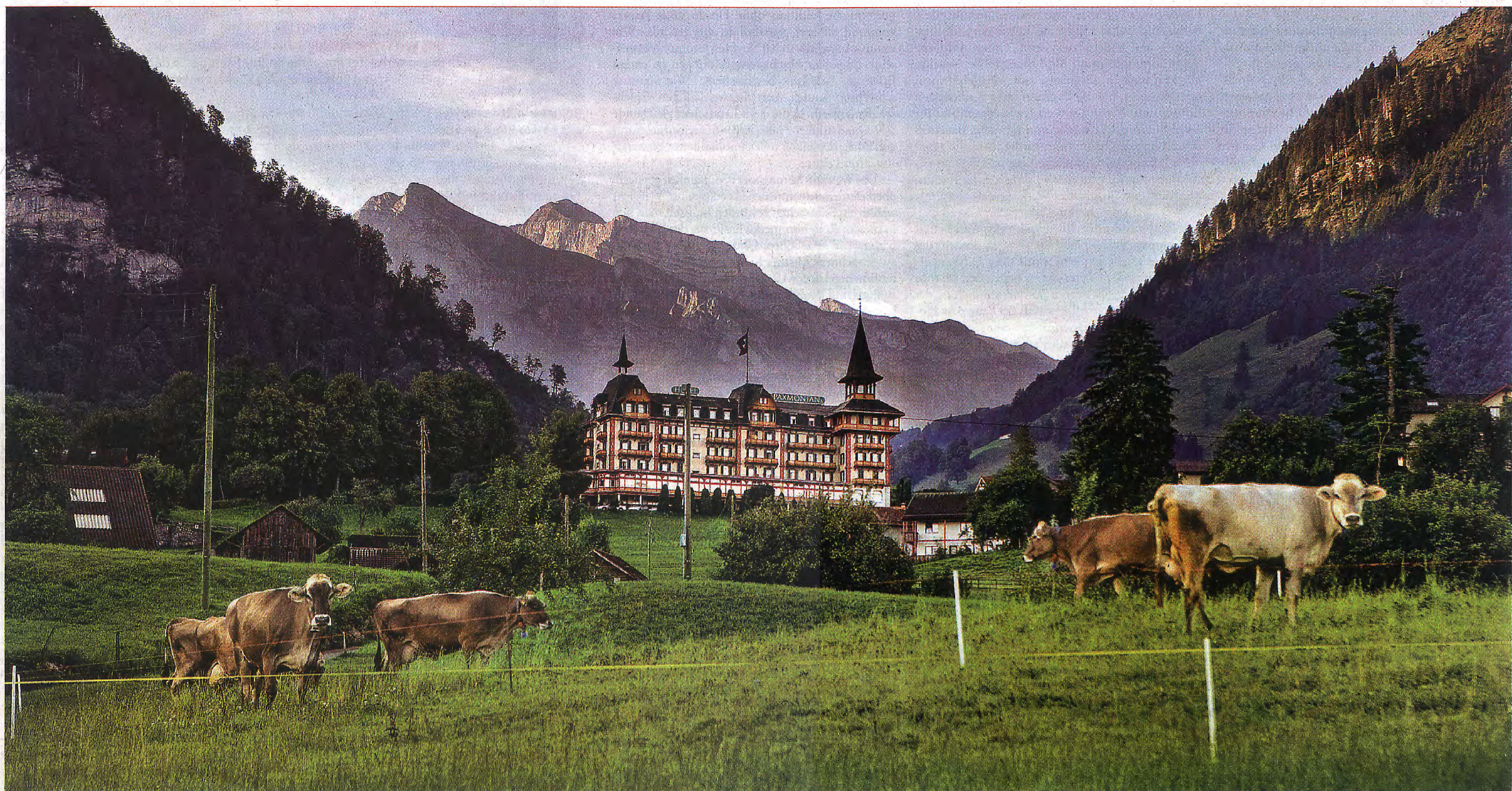
Die Jugendstilpracht des 1906 erbauten Hotels PAXMONTANA in der Zentralschweiz hat Flauten und Renovierungen überstanden
