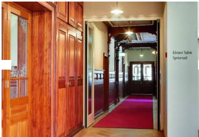
Abschluss im Erdgeschoss: Wo nicht anders möglich, wurden die Türen mit Gläsern versehen, damit sie möglichst wenig auffallen.
