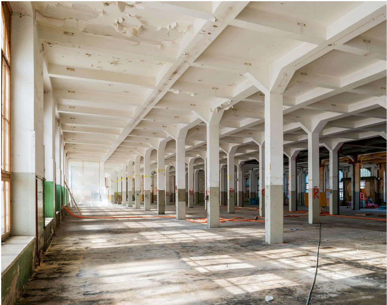
Eine der hellen, grosszügigen Fabrikationshallen während des Umbaus.
