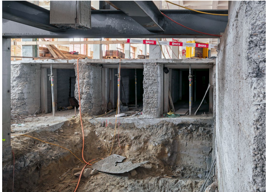
Der Anschluss der Bahnstabsunterführung an das Hamel-Gebäude erforderte einen massiven Eingriff in dessen Untergeschoss. Gut zu erkennen sind die dicht gesetzten Schotten aus Stampfbeton: Sie bildeten eine Wabenstruktur, deren Kammern bei Hochwasser geflutet wurden, was das Gebäude beschwerte und stabilisierte.
