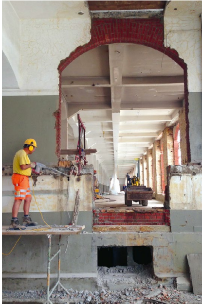
Rückbauarbeiten unter der Passerelle: Die Passerelle im 1. Obergeschoss diente der innenräumlichen Verbindung mit dem gesamten ursprünglichen Spinnereiareal.
