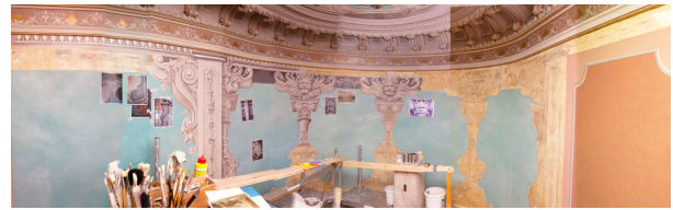
2. Obergeschoss Treppenhaus Zwischenstand Wandmalerei
