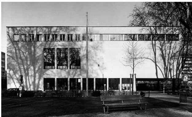
Ansicht Süd nach der Gesamtrenovation
