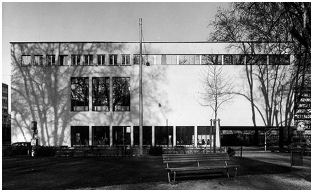
Ansicht Süd nach der Gesamtrenovierung
