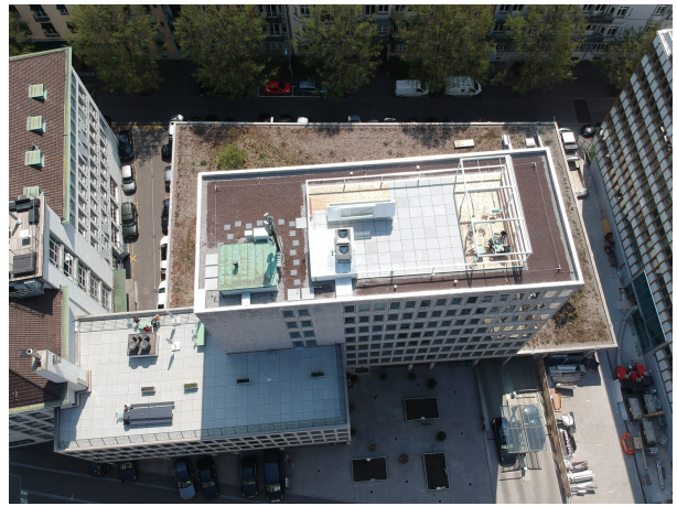
Dachterrassen nach Sanierung / Neubau
