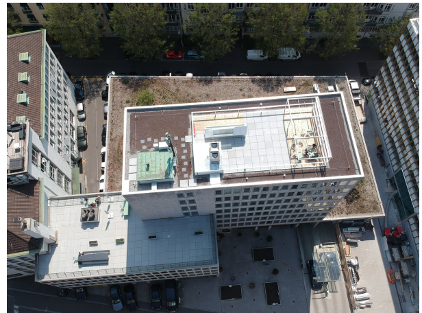
Dachterrassen nach Sanierung / Neubau
