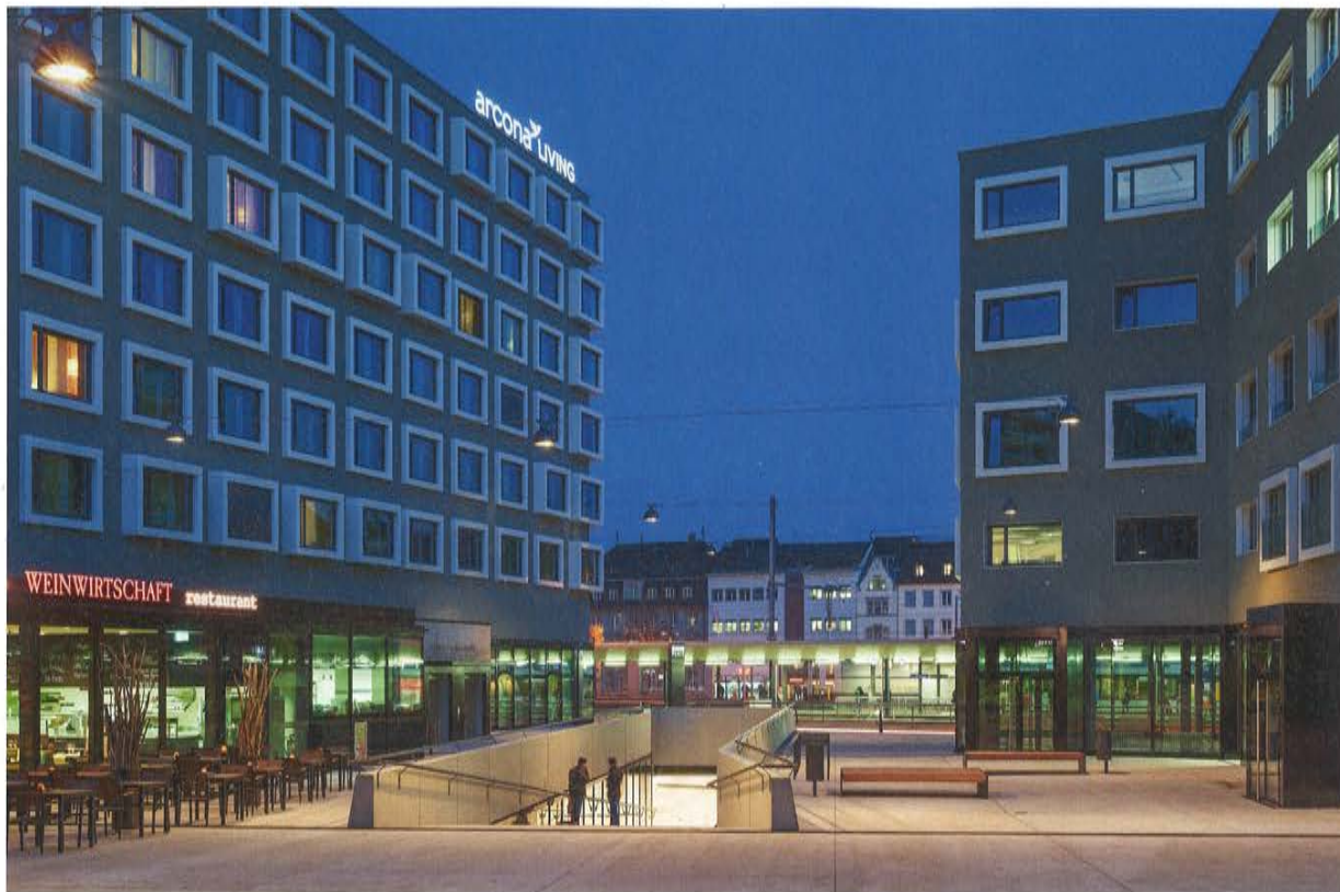
Blick vom zentralen Platz auf die Bahngleise, den Bahnhof und die dahinterliegende Altstadt. Alt und Neu liegen nur einen Steinwurf voneinander entfernt, die Sichtbezüge sind allgegenwärtig und sorgfältig inszeniert.
