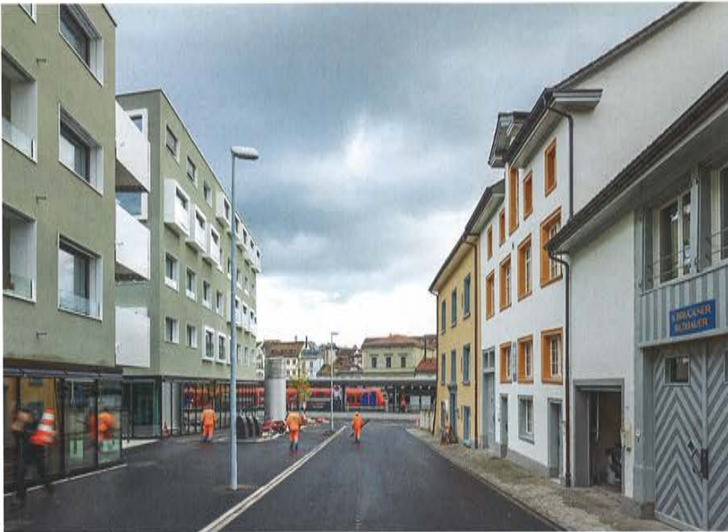
Blick vom Hintersteig zu den Bahngleisen und zur Altstadt: Die Neubauten sind auf dieser Seite aus Rücksicht auf die historischen Nachbarhäuser etwas niedriger .
