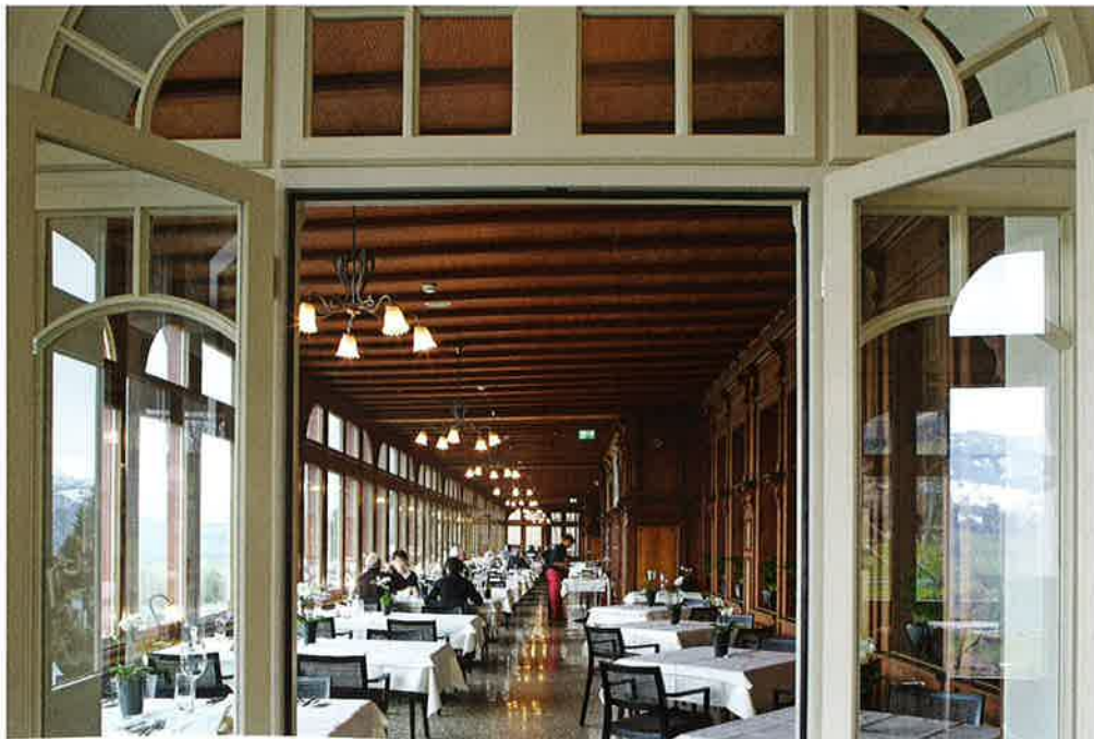
Sachseln: Hotel Paxmontana Abb. 8 Die Glasveranda wurde 1898 angebaut und 1906 verlängert. 2001 wurde der Terrazzoboden restauriert. Aktuell wurden die Fenster von 1983 ersetzt und Akustikelemente in das Deckentäfer eingefügt.
