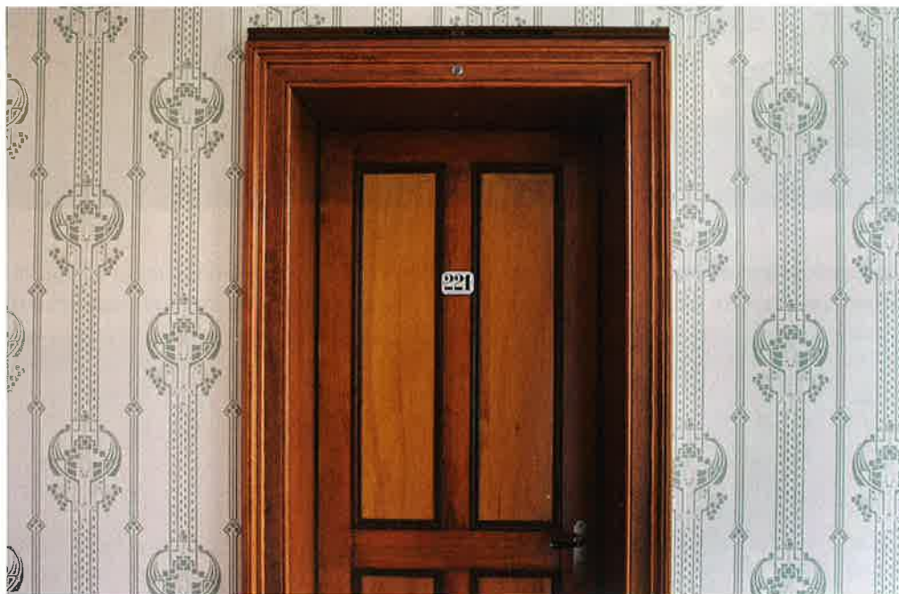
Sachseln: Hotel Paxmontana Abb. 12 Die Zimmertüren wurden aus Schall- und Brandschutzgründen zimmerseitig aufgedoppelt, auf der Korridorseite zeigt sich noch das ursprüngliche Türblatt. Die Email-Schildchen wurden nach Originalvorlagen, jedoch mit den aktuellen Zimmernummern hergestellt. Bemerkenswert ist auch die rekonstruierte Jugendstil-Tapete, die nach Befund auf einer alten Tapetendruckmaschine mit Leimfarbe nachgedruckt wurde.
