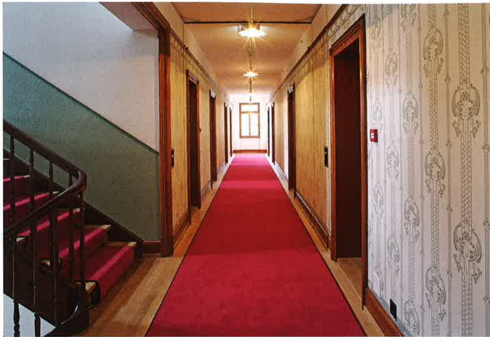
Sachseln: Hotel Paxmontana Abb. 11 Die Korridore in den Obergeschossen wurden von den nachträglichen Badezimmer-einbauten befreit und wieder mit Fenstern versehen. Die erforderlichen Brandabschlüsse zu den beiden Treppenhäusern konnten diskret in die Wände integriert werden.
