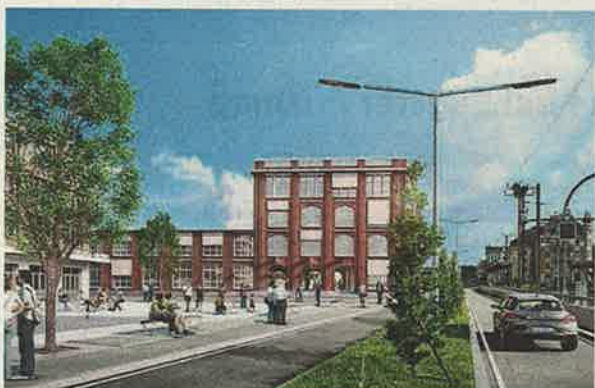
Das Hamel-Gebäude wird in den Ursprungszustand versetzt.
