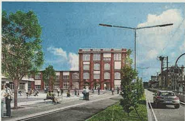
Das Hamel-Gebäude wird in den Ursprungszustand versetzt.
