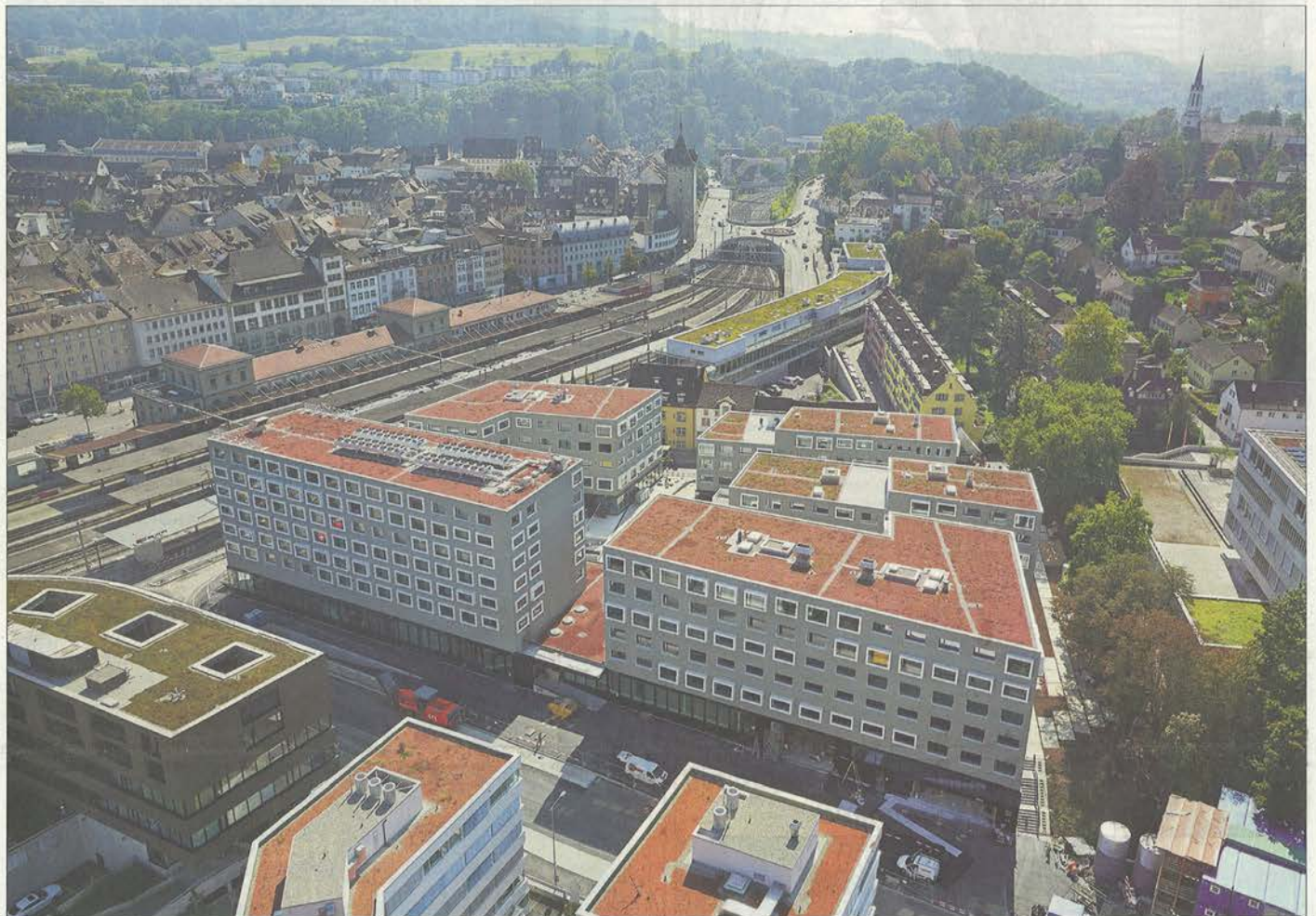
Mit dem Bau des neuen Stadtquartiers auf dem Bleicheareal ist die Symbiose zwischen urbanem Städtebau und der historischen Altstadt von Schaffhausen geeglückt.
