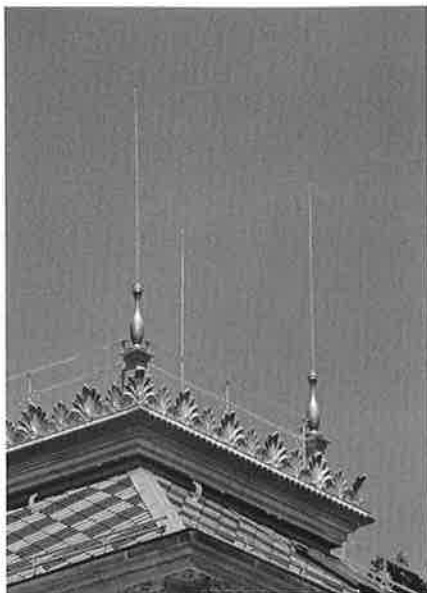
Rekonstruierter Dachkranz Couronne du toit reconstruite
